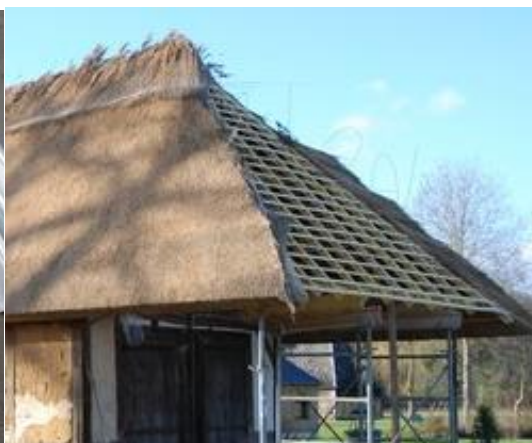
Toiture type chaume
