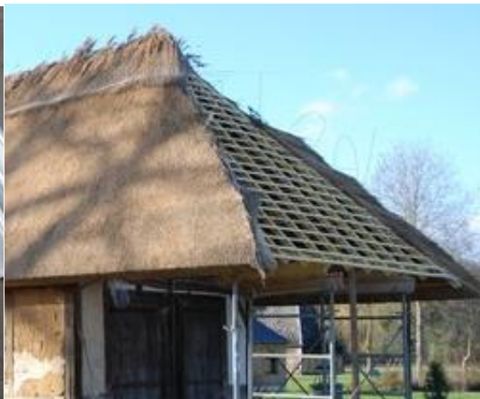
Toiture type chaume
