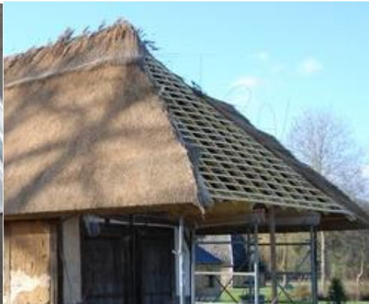
Toiture type chaume
